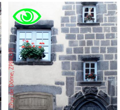
En cas de parement mixte (avec des parties en pierre appareillée) il pourra être préférable de réaliser un enduit sur la maçonnerie de moellons plutôt que de mettre en œuvre un aspect "grélé". Tout sera affaire d'appréciation.
