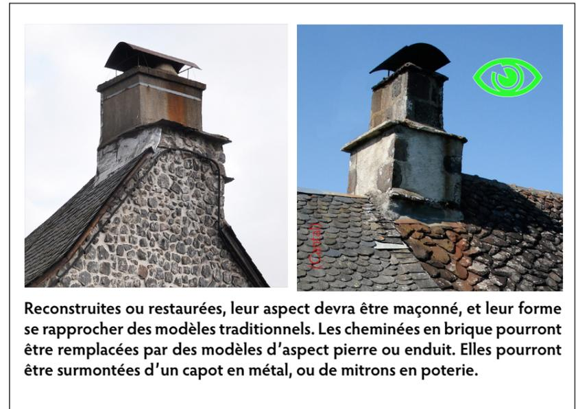
Reconstruites ou restaurées, leur aspect devra être maçonné, et leur forme se rapprocher des modèles traditionnels. Les cheminées en brique pourront être remplacées par des modèles d'aspect pierre ou enduit. Elles pourront être surmontées d'un capot en métal, ou de mitrons en poterie.
