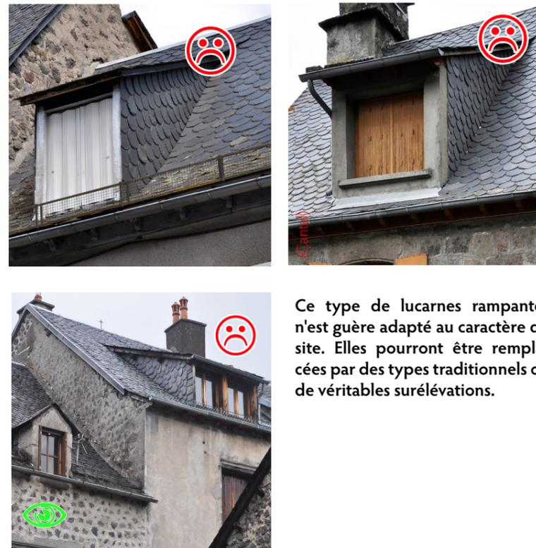
Ce type de lucarnes rampantes n'est guère adapté au caractère du site. Elles pourront être remplacées par des types traditionnels ou de véritables surélévations.
