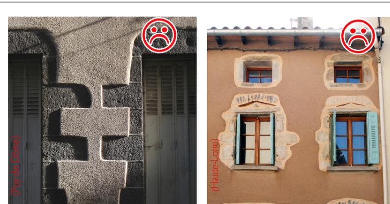
Exemples d'enduits réalisés de manière erronée : on ne doit pas grossièrement détourner les pierres de grande taille, ou les arcs de décharge, eux aussi destinés à être recouverts.
