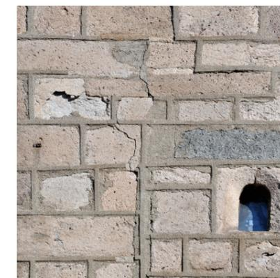
Il est possible que des parements dégradés ne puissent être conservés en l'état. Il conviendra alors d'apprécier s'il doit être remplacés par un enduit ou simplement chaulés (lait de chaux couleur pierre), qui renforcerait leur protection défailante.
