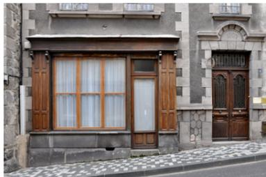
...et la devanture en applique, celle-ci étant un ouvrage de menuiserie en légère saillie sur la façade, fermant une baie uniquement fonctionnelle. Ce dispositif est le plus répandu à Murat.
