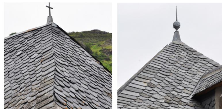
Il est nécessaire de réaliser arêtiers et noues à joints vifs et non à l'aide de bandes métalliques pliées (valable pour la lauze et l'ardoise).
