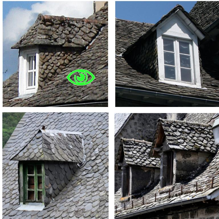
Il existe dans le Cantal, deux types principaux de lucarnes traditionnelles: la lucarne à croupe (dite "à la capucine") et la lucarne en chevalet (dite "à fronton" ou en batière). Les joues peuvent être maçonnées, ou couvertes de lauzes ou d'ardoise, si la structure en est en bois. Ces lucarnes, lorsqu'elles existent, devront être conservées et entretenues. (clichés pris dans le Cantal)
