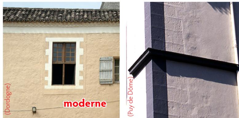
Le décor sur badigeon le plus simple, très répandu dans l'architecture traditionnelle, consiste en la simulation d'une modénature (comme les chaînes d'angle, droites ou en harpe) ou les encadrements d'ouvertures.
