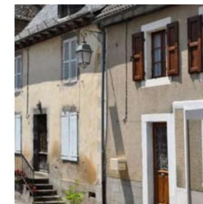
L'objet de l'enduit est en fait triple : protéger une maçonnerie souvent sommaire, contribuer à isoler la paroi et simuler une architecture, en général régulière. De plus, chaque construction peut ainsi s'individualiser au sein d'un ensemble, dans des limites bien définies.
