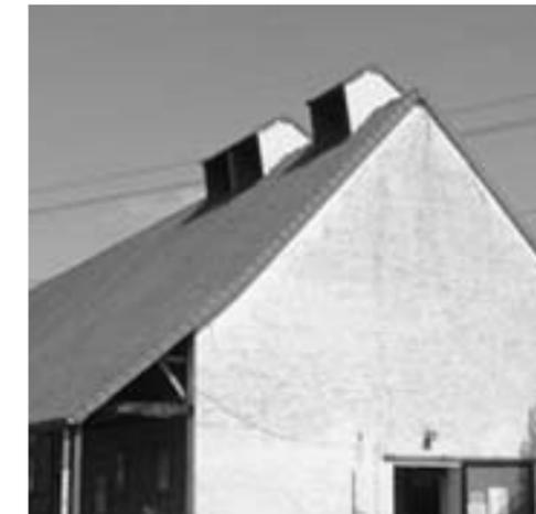
Une éolienne de toiture (document du fabricant)
