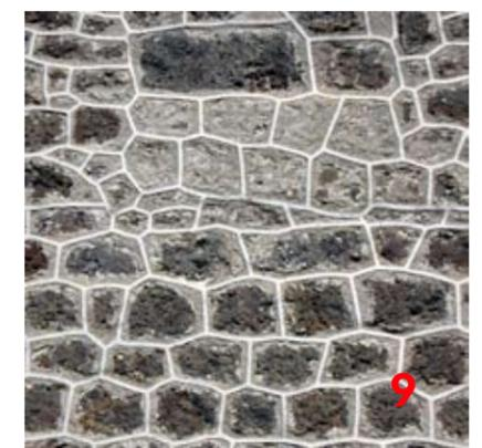
Il existe également un aspect "intermédiaire" (7-8) entre la pierre appareillée et la maçonnerie de moellons décapée. Les lits sont plus ou moins réguliers, les joints très épais. Cette maçonnerie de "grosses" pierres pourrait provenir de récupération. Sauf dans le milieu rural, il n'est pas avéré que cette maçonnerie soit destinée à rester visible.
