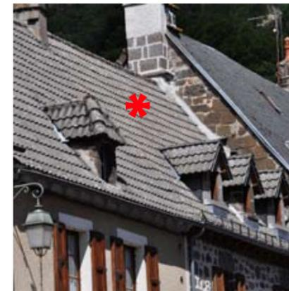
Plusieurs toitures du village ont été refaites par le passé en tuiles mécaniques grand moule, d'aspect côtelé, qui ont altéré l'aspect général des toitures, sans toutefois introduire une trop grande rupture.
