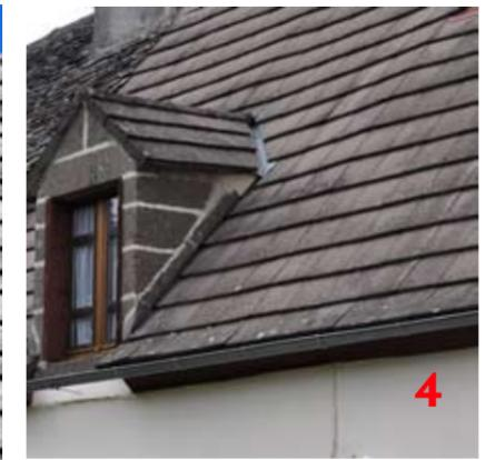
Divers types de tuiles ont été utilisés : la tuile mécanique grand moule "à côte" (1) ou ondulation (2-3), plus rarement une tuile plate (3) matériau incorporant sans doute de l'amiante).
