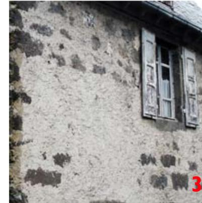
D'une manière générale, l'architecture du passé à base de moellons est enduite, avant les modes modernes du décrépiage. Il s'agit en fait de protéger une maçonnerie parfois douteuse des intempéries et d'isoler la construction. Ces enduits sont parfois simplement chaulés (1). C'est leur usure qui fait souvent réapparaître la pierre (2).
