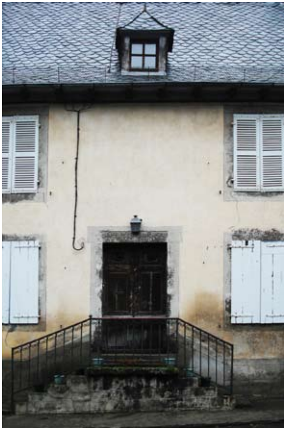
Maison du milieu XIXe, refaite vers 1900 avec un badigeon sur enduit fin. On peut également se caler sur cet état pour retrouver un badigeon légèrement coloré. Toutefois, cette coloration doit rester assez discrète pour ne pas détonner dans l'ensemble.
