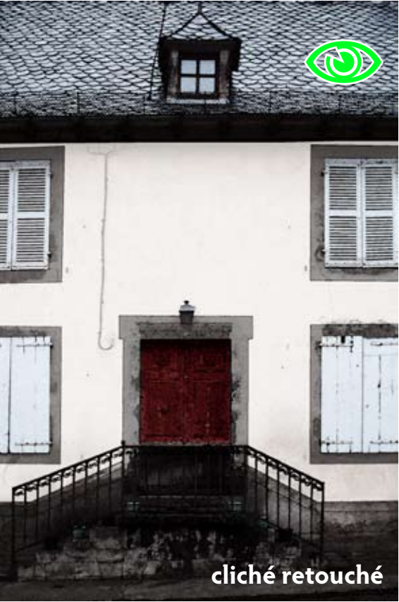
Maison du milieu XIXe, refaite vers 1900 avec un badigeon sur enduit fin. On peut également se caler sur cet état pour retrouver un badigeon légèrement coloré. Toutefois, cette coloration doit rester assez discrète pour ne pas détonner dans l'ensemble.
