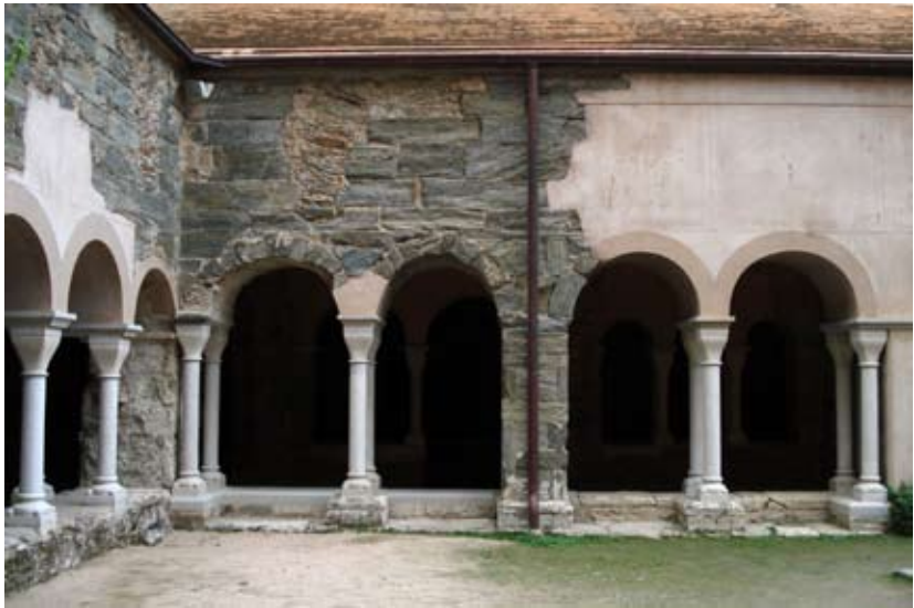
Compléments et parties authentiques permettent de reconstruire l'image du cloître en grande partie disparu. En différenciant nettement le vrai du faux, on évite la falsification, tout en "réparant" visuellement l'ouvrage. (St Pere de Rodes, Catalogne).
