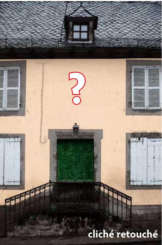
Maison du milieu XIXe, refaite vers 1900 avec un badigeon sur enduit fin. On peut également se caler sur cet état pour retrouver un badigeon légèrement coloré. Toutefois, cette coloration doit rester assez discrète pour ne pas détonner dans l'ensemble.
