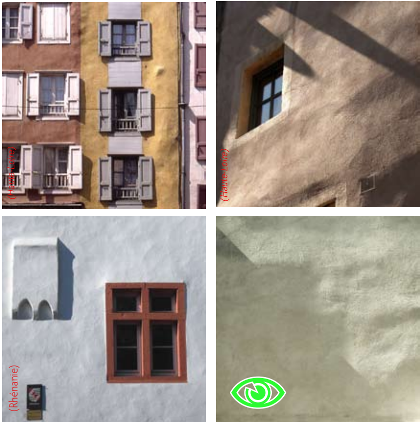
Les supports les plus anciens sont parfois très irréguliers. L'enduit doit suivre ces irrégularités, sans chercher ni à les masquer, ni à les accentuer.
