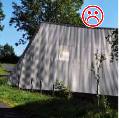
Pour les grands volumes traditionnels à usage agricole, difficiles à recouvrir en lauze ou ardoise compte-tenu de leur fonction, il pourra être fait usage de matériaux métalliques adaptés.
