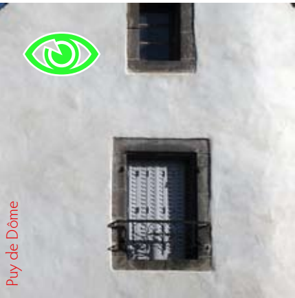
Assez bon exemple d'enduit à l'imitation des enduits anciens de type traditionnel : détourage régulier des ouvertures, teinte très claire façon chaux, suivi des irrégularités de la façade, grain fin (dans une ZPPAUP).
