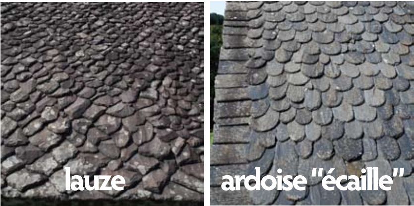
Les matériaux traditionnels les plus répandus : lauze et ardoise taillée en écaille
