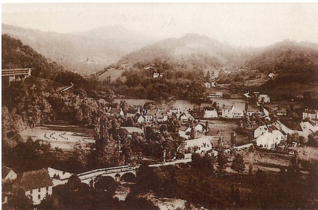
Vendes – Vue générale, au fond les mines de Champleix.
