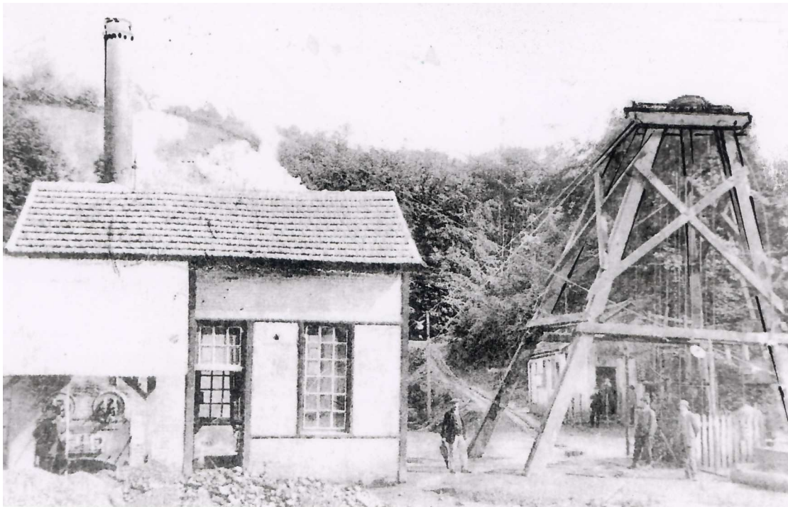
Le puits de la Gineste en 1915.
