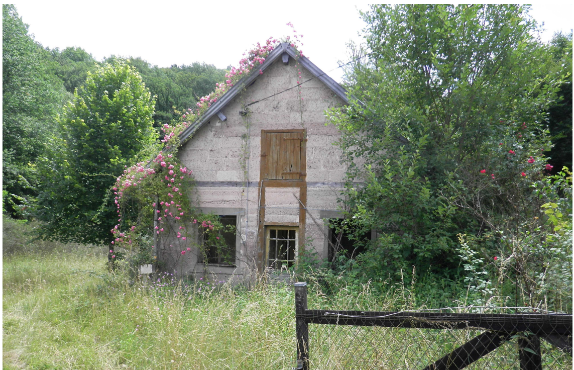
le carreau (bureaux)
