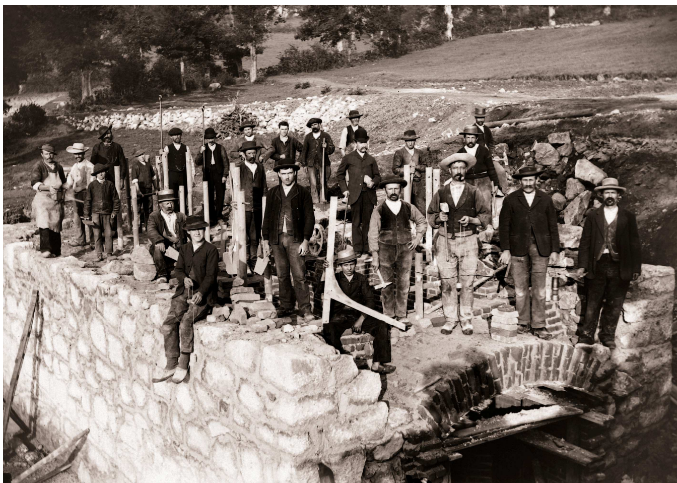
1912 – Construction de l'enceinte du four à coke (Photo de Mme. Pochat).
