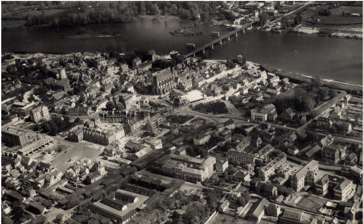
Les chantiers du centre ville de Vernon vers 1950.
