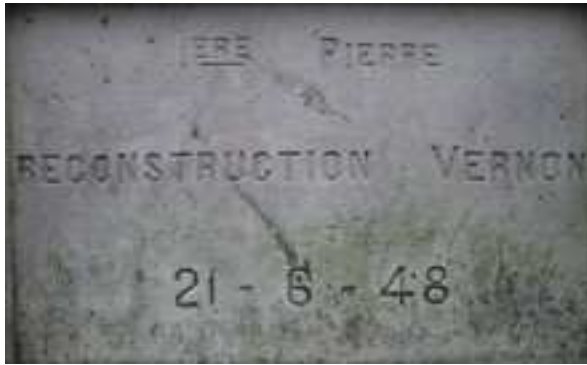
Première pierre de la reconstruction au 23 de la rue Émile-Steiner
