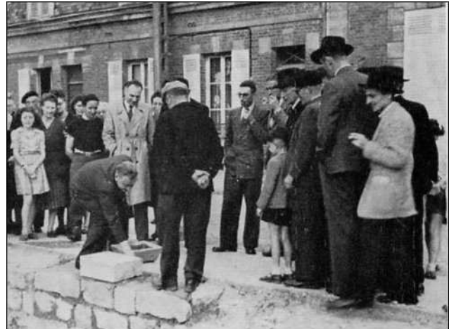
Pose de la première pierre de la reconstruction de Vernon, rue Émile-Steiner par Georges Azémia en 1948. Ce dernier est entouré de Lizée, directeur départemental de la construction ; Pochat, ingénieur des Ponts et Chaussées, Dhérin et James, adjoints au maire ; à droite, une cigarette à la main, Jean Tessier, l'architecte, collaborateur d'Henry Pottier.
