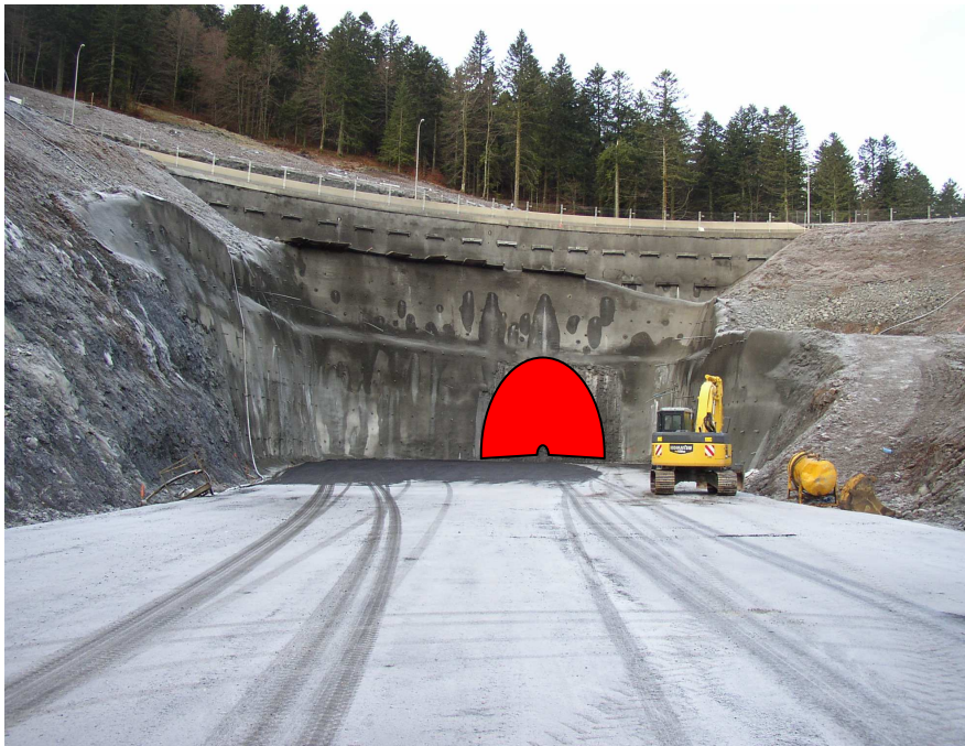
Livraison de la plateforme côté Murat
