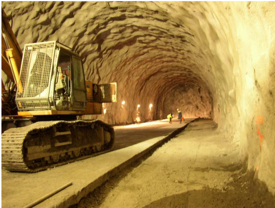
Fin de l'excavation côté Aurillac
