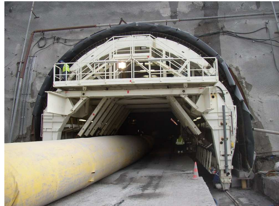
Bétonnage du 1 er anneau béton
