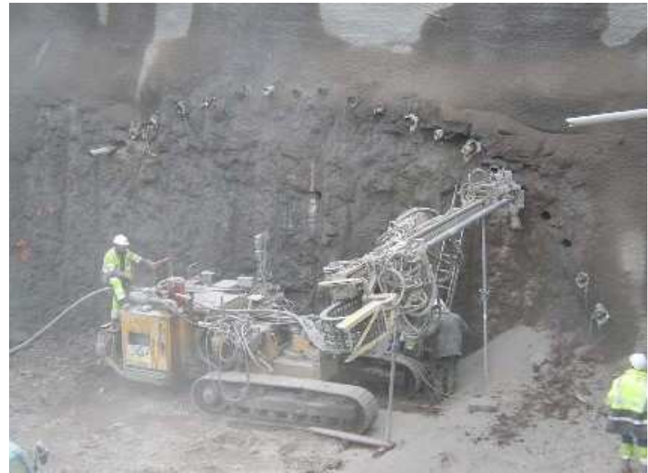
Voûte parapluie en cours de forage
