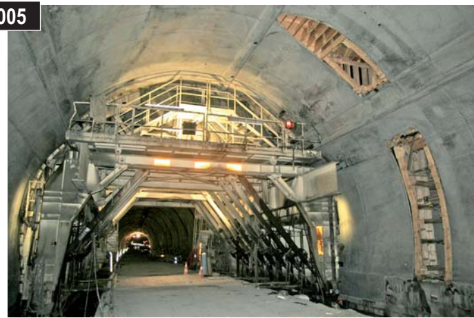
Le même coffrage après revêtement béton
