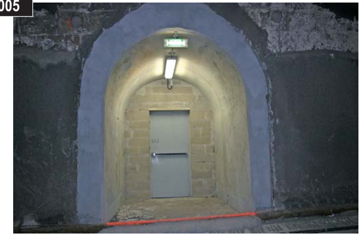
Vue d'une sortie de secours dans l'ancien tunnel
