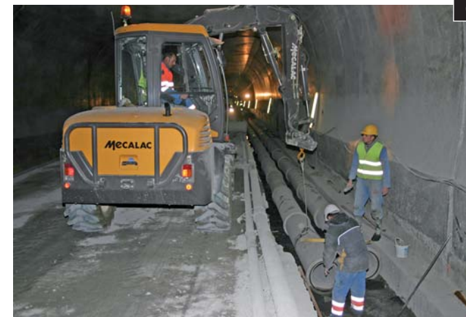
Pose de 93 000 ml de drains, fourreaux et collecteurs
