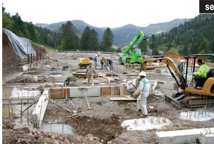
Début des travaux du centre de secours (dépôt des Sagnes)
