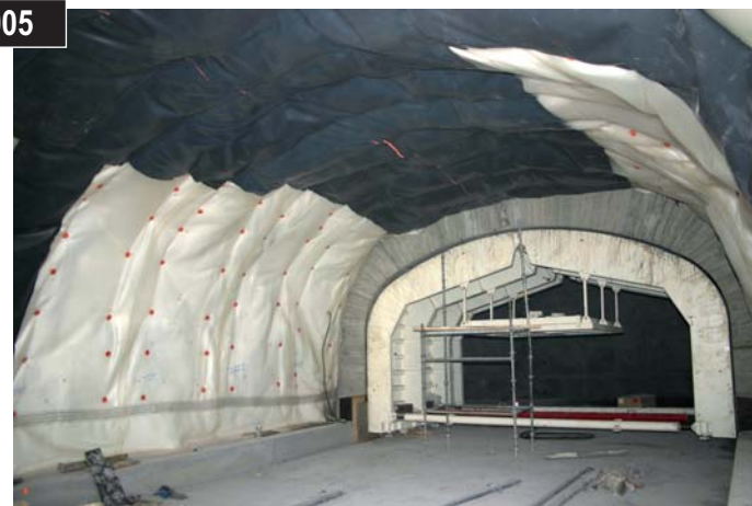
Etanchéité et coffrage de l'aire de retournement
