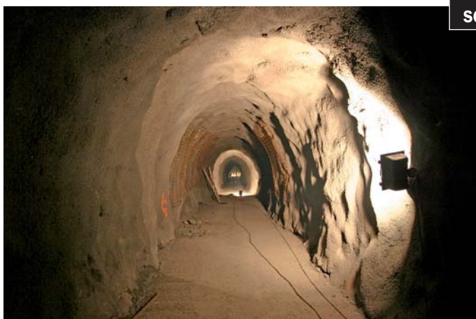
Galerie de sécurité en phase d'achèvement...
