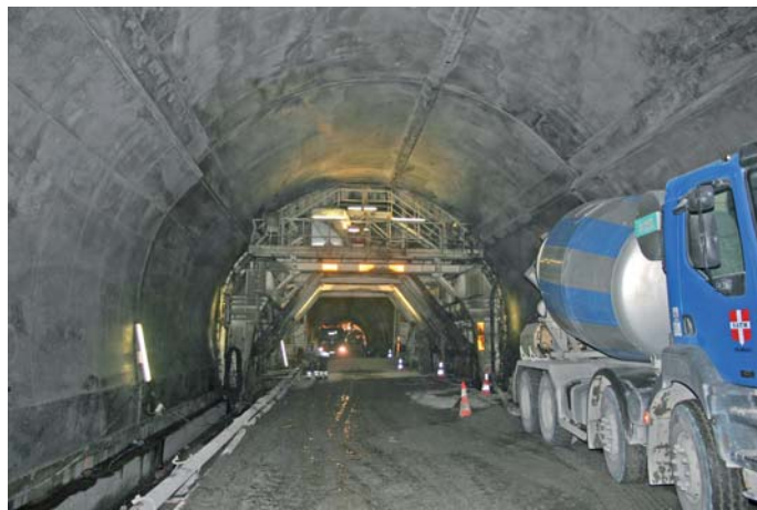
6600 toupies ont approvisionné 40 000m 3 de béton
