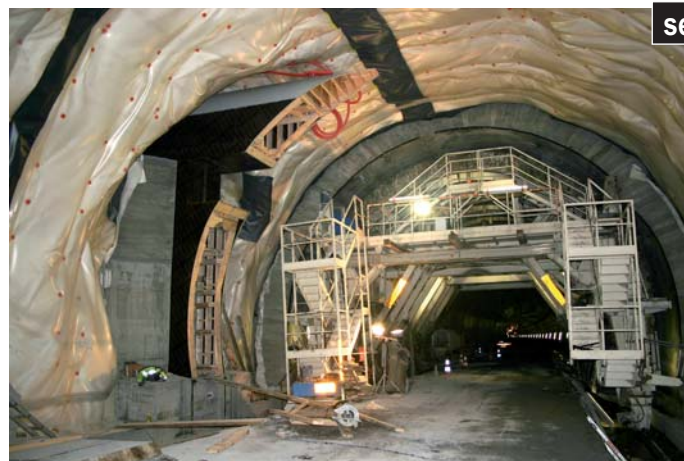
Coffrage de l'escalier d'accès aux gaines de ventilation
