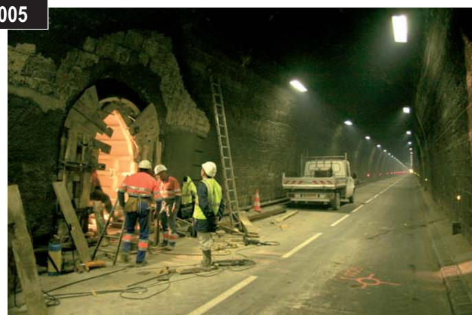
Coffrage d'un sas de raccordement dans l'ancien tunnel
