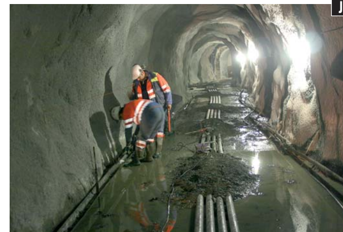
Galleries sécurité: préparation avant coulage du radier
