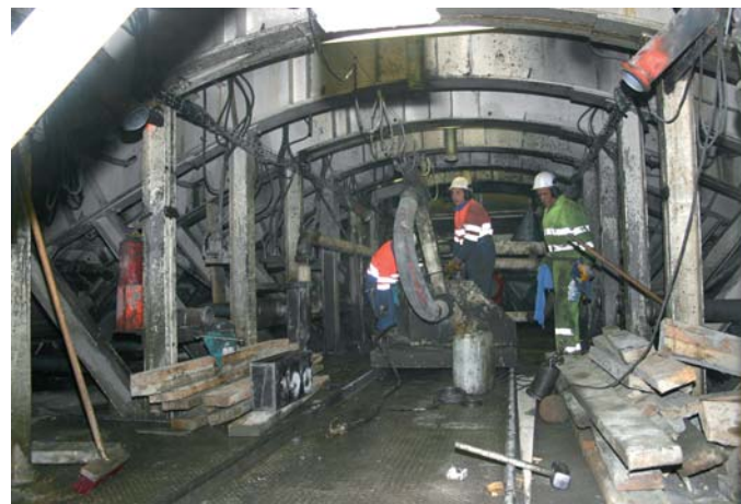
Une pompe sur rails répartit le béton sur l'outil coffrant
