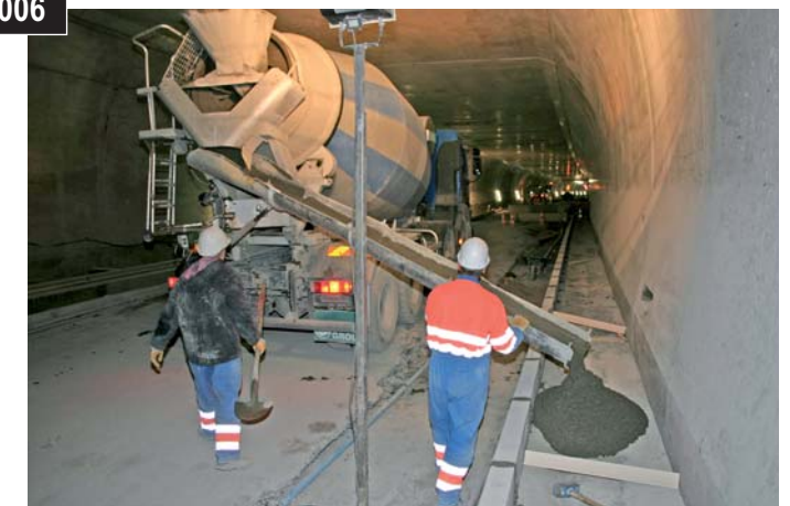
Bétonnage des trottoirs après pose de bordures béton
