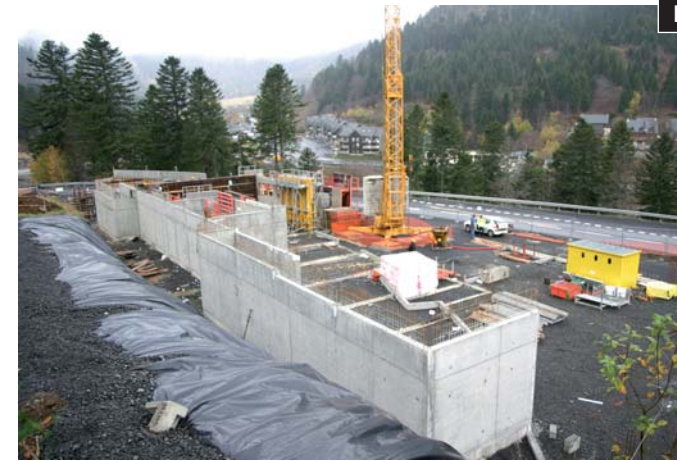
Le futur centre de secours commence à sortir de terre
