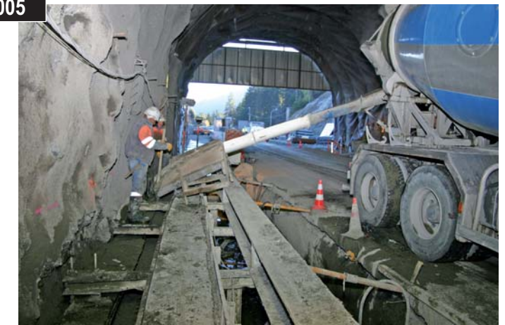
Réalisation des derniers mètres de banquettes
