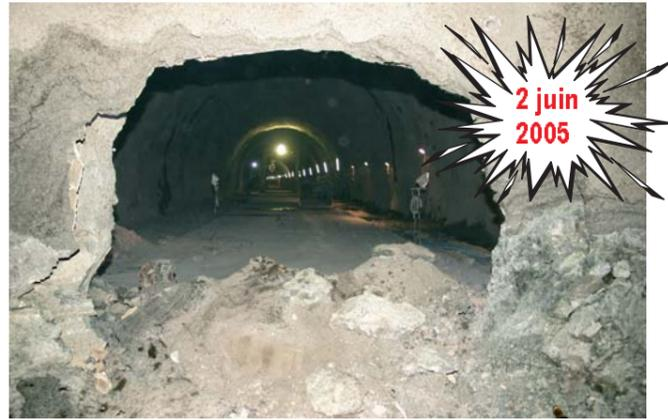
Dernier tir de mine et fin du creusement du tunnel...
