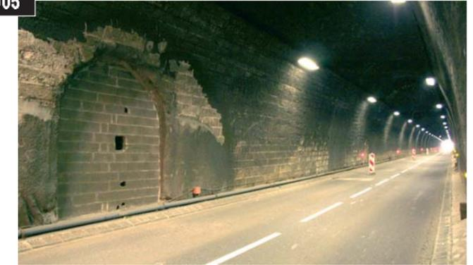
Les 4 galeries de secours sont creusées, leur débouché dans l'ancien tunnel est provisoirement sécurisé par un mur en parpaings.
