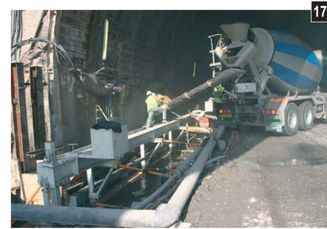
Coulage des banquettes dans un coffrage métallique
