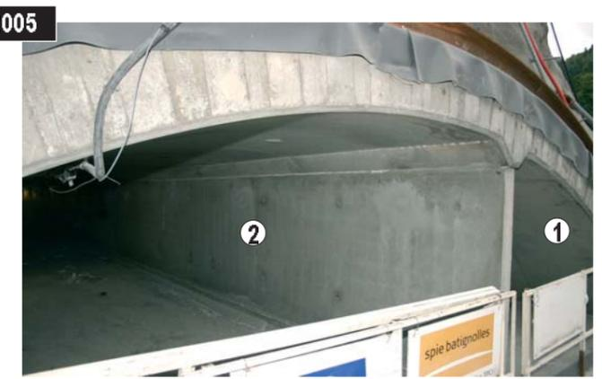
La cloison séparera le conduit d'air frais (1) de celui de désenfumage (2) en cas d'incendie dans le tunnel
