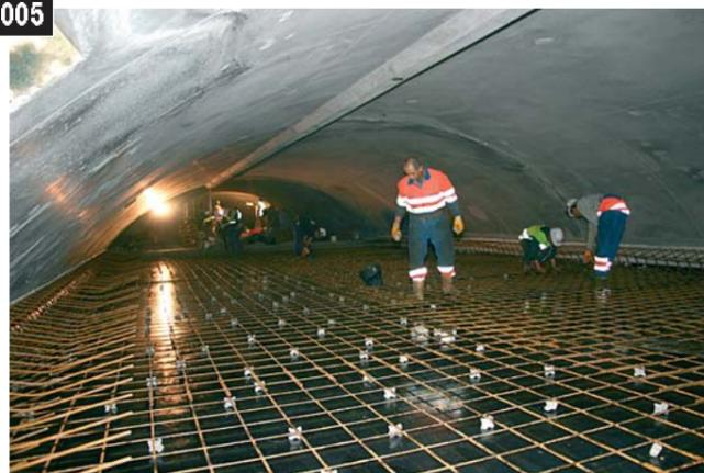
Ferrailage de la dalle plafond avant coulage
