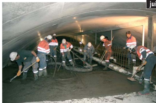
Mise en oeuvre du béton (coulage) de la dalle plafond
