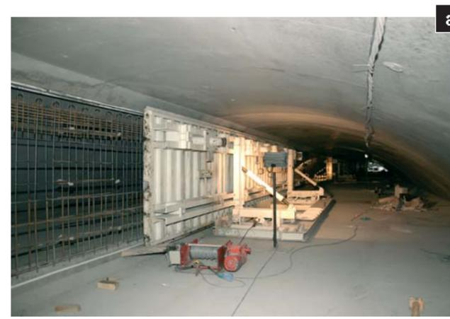
Coffrage de la cloison des conduits sur dalle plafond
