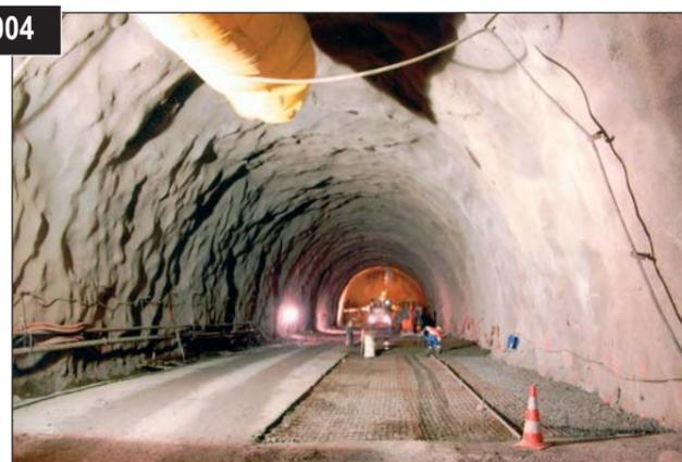
La construction du radier avance avec le percement
